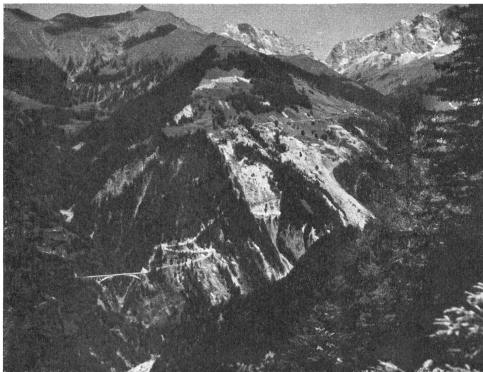
Abb. 31 Ansicht des Schuderser Rutschgebietes von S.W. mit dem Salginatobel und der kühn geschwungenen Betonbrücke. (Pfeil: Lehnmauer bei Fadiel.) Photo Mischol, Schiers.
