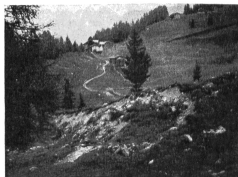
Abb. 17 Die rutschreife und angerissene Partie beim Serneuser Dorfbach bildete 1939 eine unmittelbare Gefahr für das Dorf. Sie wurde durch sofortige Quellen-Entwässerung zum Stehen gebracht und gleichzeitig konnte eine Serie projektierte Sperren eingespart werden.
