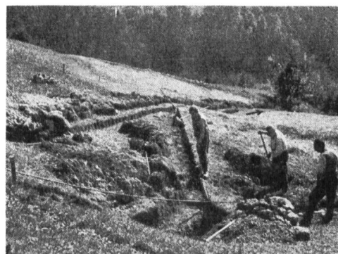
Abb. 29 Quellenfreilegung bei Schuders.
