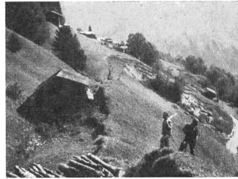
Abb. 26 Ganze Ställe versinken in den klaffenden und immer näher an Schuders hinübergreifenden Spalten. Dieser Stall wurde bereits viermal aufgerichtet und ist heute unbenütztbar. Photo Dr. Stauber
