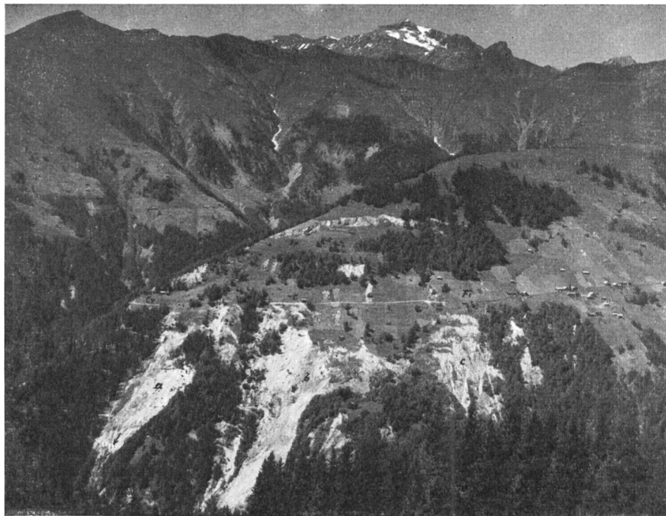
Abb. 21 Ansicht der Schuderser Rutschungen von Oberstels aus.
