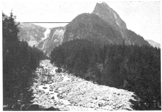
Abb. 5 Hochwasserschäden im September 1927.
