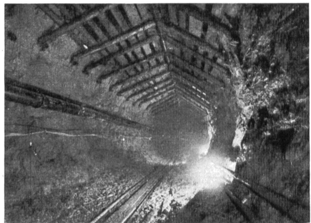
Abb. 8 Aushub des Druckstollens und Stirnschutz gegen das Fallen von Felsblöcken im Los III.
