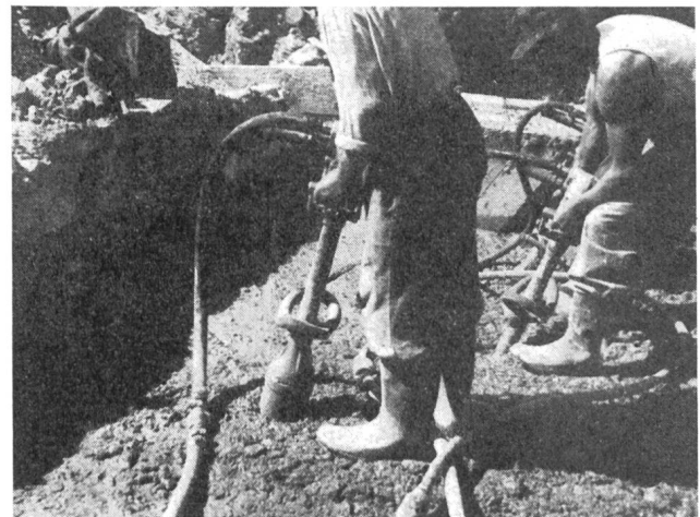
Abb. 16 Staumauer, Betonrüttler.
