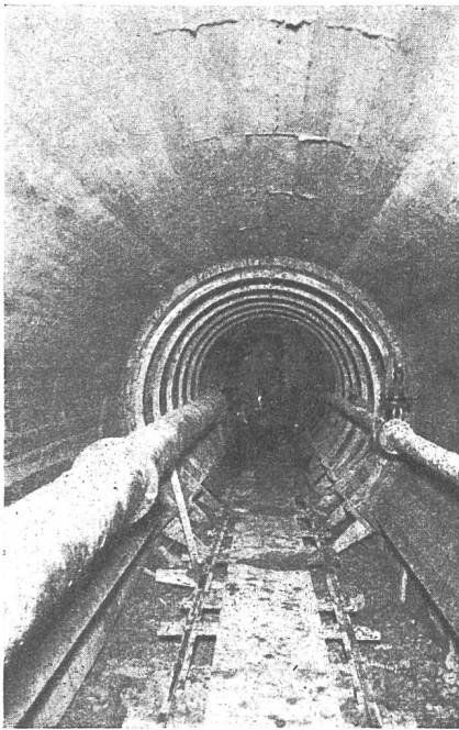
Abb. 19 Ausbetonierter Stollen mit eiserner Schalung.
