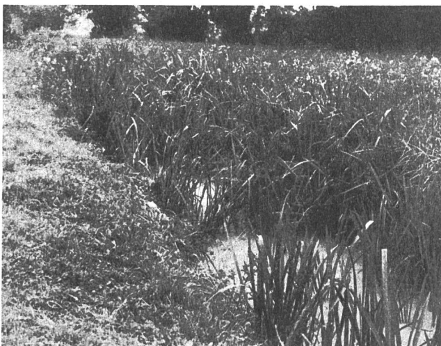
Abb. 6 Verkräutung im Graben ohne Sohlensicherung.
