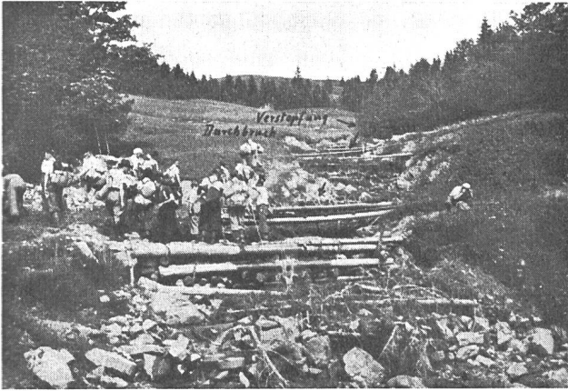
Abb. 12 Provisorische Verbauung des Wissibaches. Photo Ing. Rieser.
