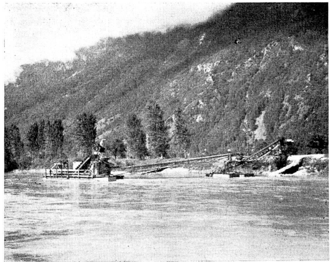
Fig. 21 Collonges 1946. Installation d'extraction des agrégats sur le Rhône.
