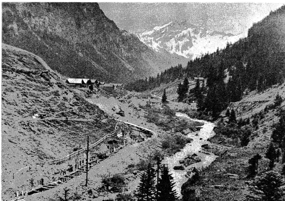
Abb. 1 Saminatal, Blick talaufwärts gegen die Wasserfassung. In der linken Bildhälfte der Rohrgraben für die Hangleitung. Im Hintergrund der «Naafkopf» (2574 m). (Photo P. Ospelt, Schaan)
