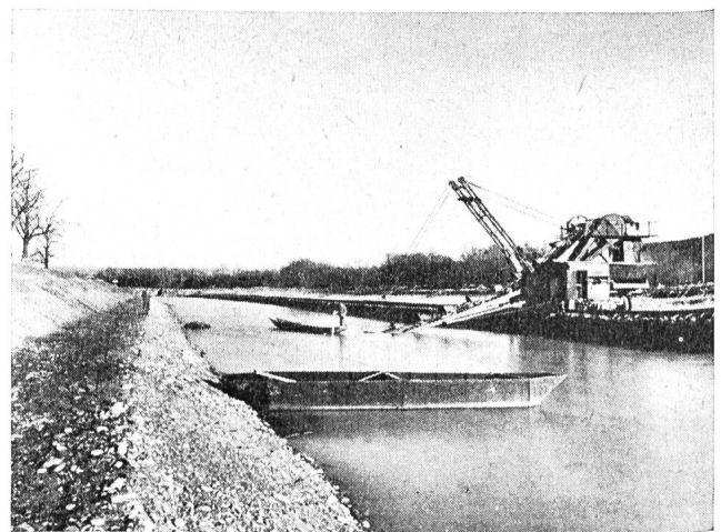
Abb. 13 Unterwasserkanal Wildeggen-Brugg, Aushub unter Grundwasser
