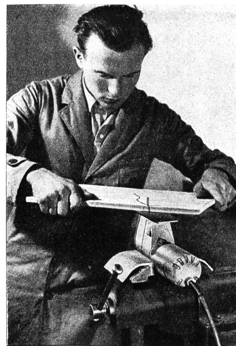
Abb. 19 Die ortsfeste Elektro-Handsäge (Scintilla)
