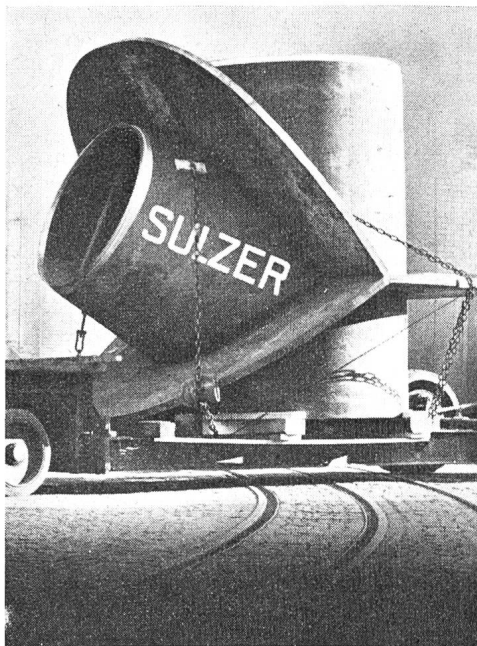
Druckleitungs-Abzweigstück von 14 Tonnen Gewicht, ausgerüstet mit Sulzer-Verstärkungskragen
