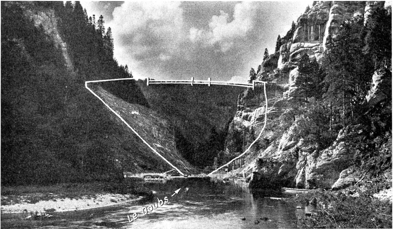
Abb. 5 Kraftwerk Châtelot, Blick auf die Sperrstelle von der Wasserseite
