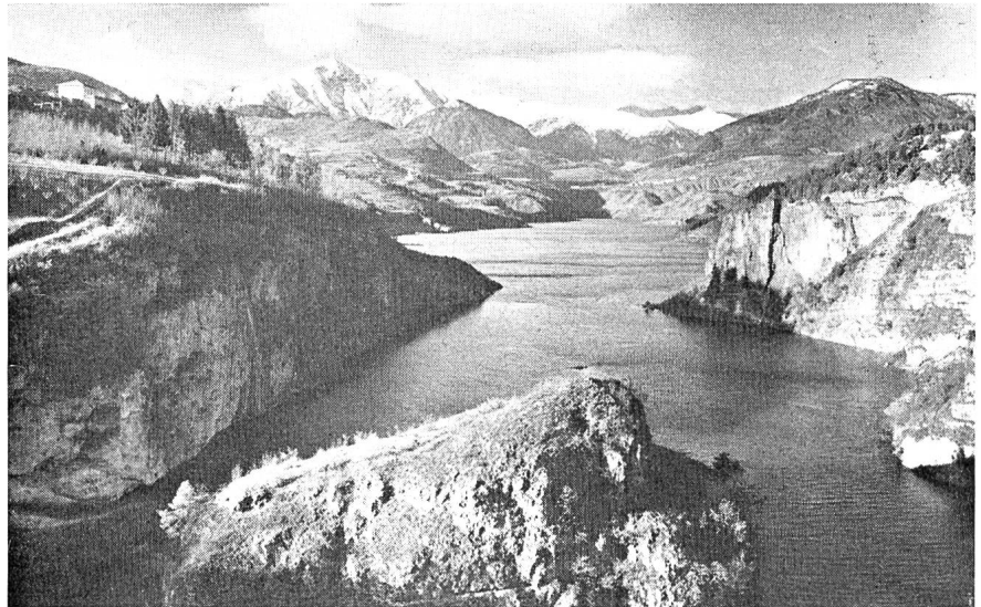
Abb. 12 Stausee S. Giustina am Noce, Blick gegen Norden (erster Teilstau) (Photo Giunta tecnica del Gruppo Edison)
