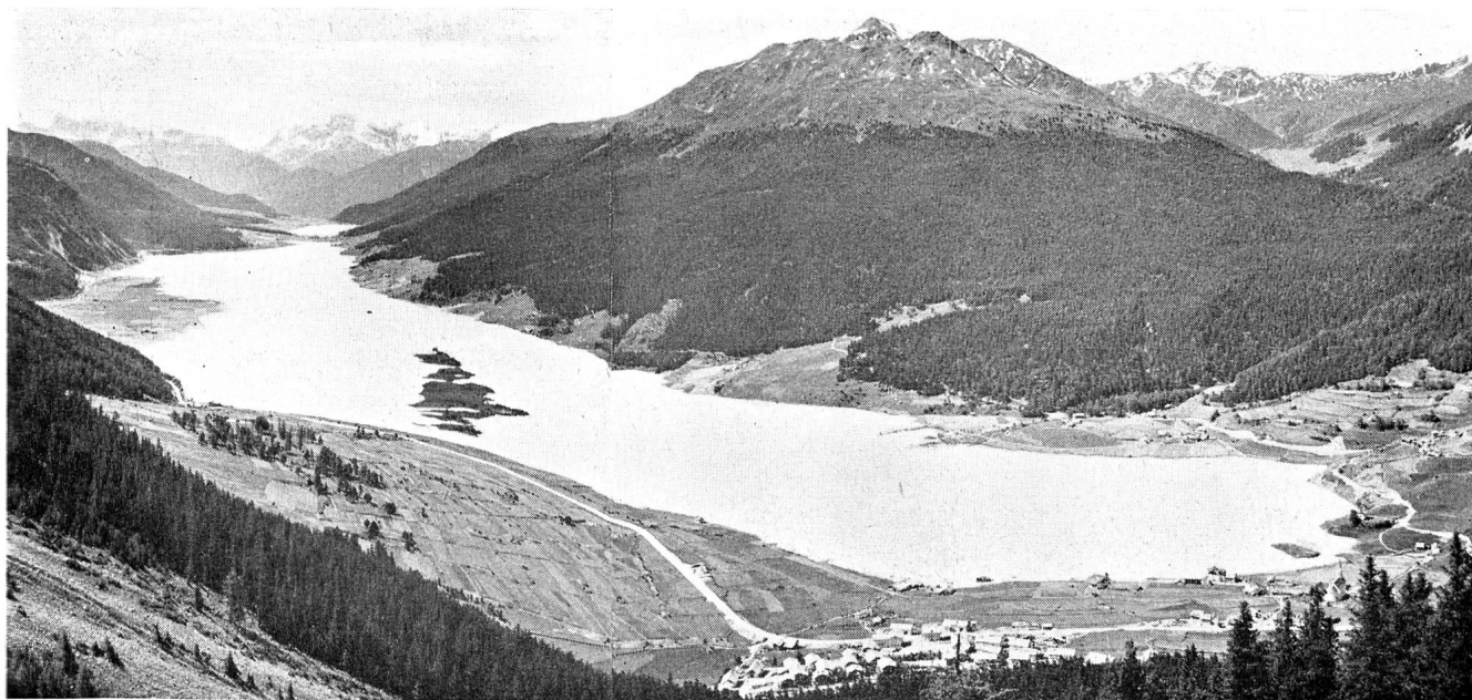
Abb. 14 Stausee Resia im Quellgebiet der Etsch, erster Teilstau, Blick gegen Süden, im Hintergrund Ortlergruppe
