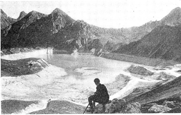
Abb. 17 Lünersee im Rhätikon, zu Abdichtungsarbeiten abgesenkt (Photo Vorarlberger Illwerke AG)
