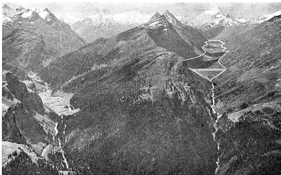
Abb. 16 Der geplante Stausee Valle di Lei im Einzugsgebiet des Averser- und Hinter- rheins (Photo Eidg. Landestopographie)
