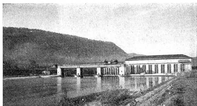
Abb. 5 Stauhaltung des Kraftwerks Reckingen
