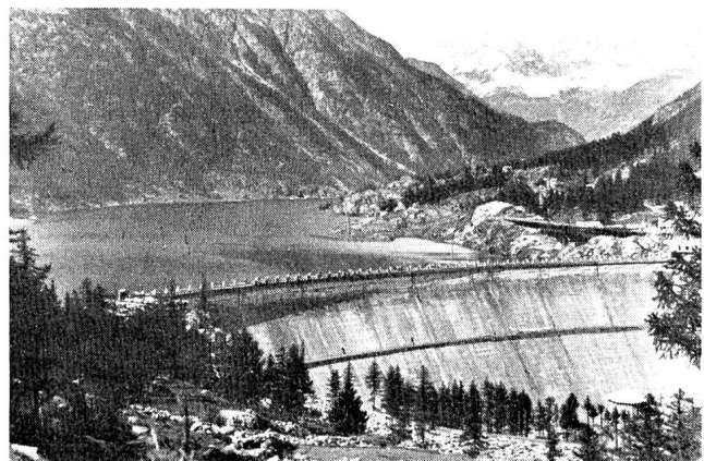
Abb. 18 Ceresole Reale, Stausee in der Valle di Locana am Orco. Rechts im Bild die kleine Nebensperre (Photo A. E. M. Torino)
