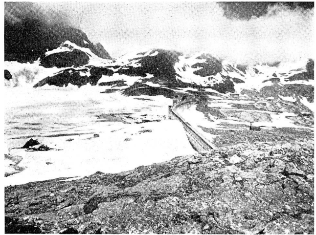
Abb. 17 Lago della Rossa, 2716 m ü. M., in abgesenktem Zustand (Photo S. E. M. Milano)
