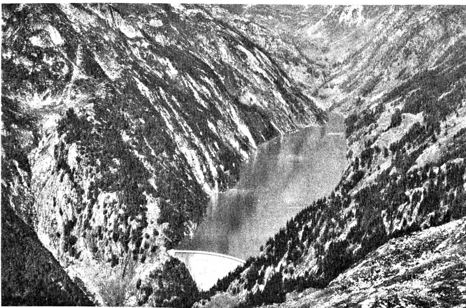
Abb. 24 Zukünftiger Stausee von Sambuco im obersten Maggiatal. Blick gegen Passo di Naret (Aufnahme der Eidg. Landestopographie, Wabern. Alle Rechte vorbehalten)
