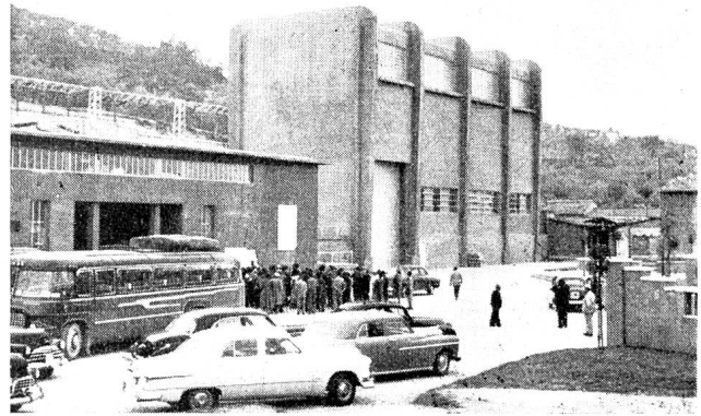
Abb. 8 Eingang zur Kavernen-Zentrale Monte Argento (Photo: H. Müller, Aarau)
