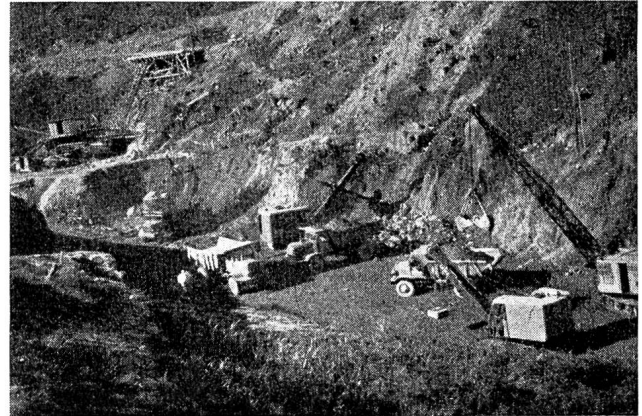
Abb. 24 Abtrag der Verwitterungsschicht an der Bergrutschflanke und Beginn der Schüttung von Material (3) im ehemaligen Juliabett
