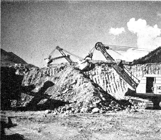
Abb. 10 Gewinnung von Kernmaterial für den Staudamm aus der Grundmoräne von Cresta
