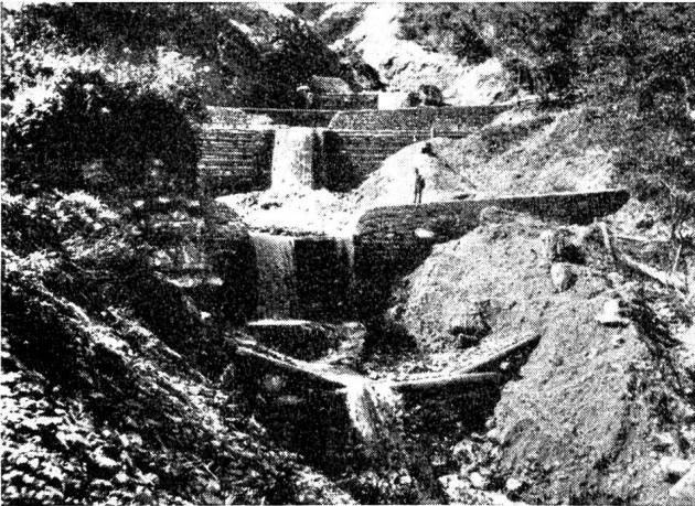
Abb. 4 Kombinierte Sperren Holz-Stein im Casolfbach (Prätigau)
