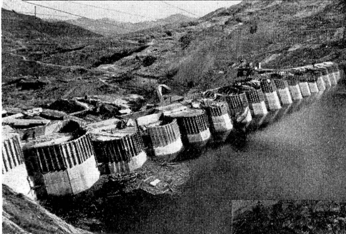
Staumauer Lucendo im Bau
