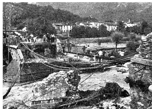
Abb. 7 Die eingestürzte Brücke der Kantonsstraße bei Taverner (Photo Marino, Bellinzona)
