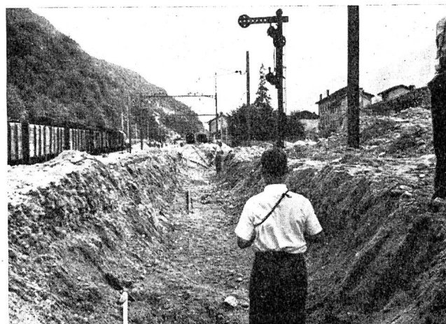
Abb. 6 Das Geschiebe bedeckt meterhoch die Geleise bei der Station Osogna-Cresciano (Photo Marino, Bellinzona)
