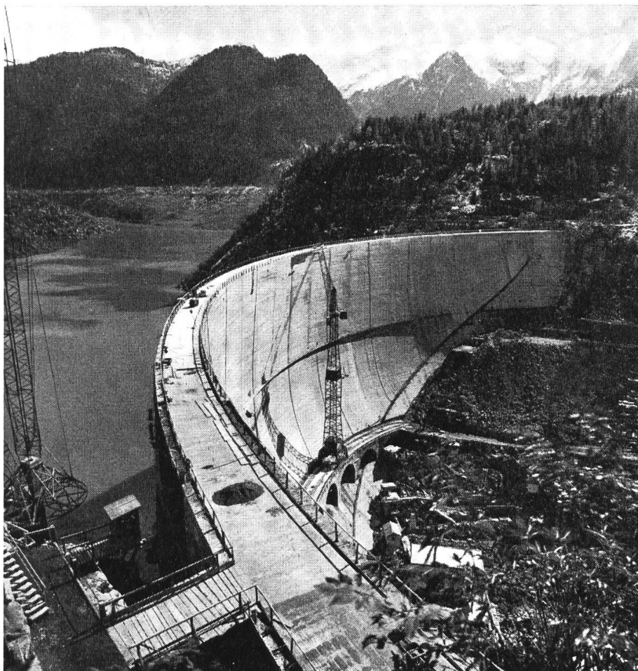
Staumauer Forte Buso (Italien) erbaut von der Smirrel, Feltre, mit FRIOPLAST-Beton (der 1. Teil wurde mit einem gewöhn- lichen Air-entrainer ausgeführt)
