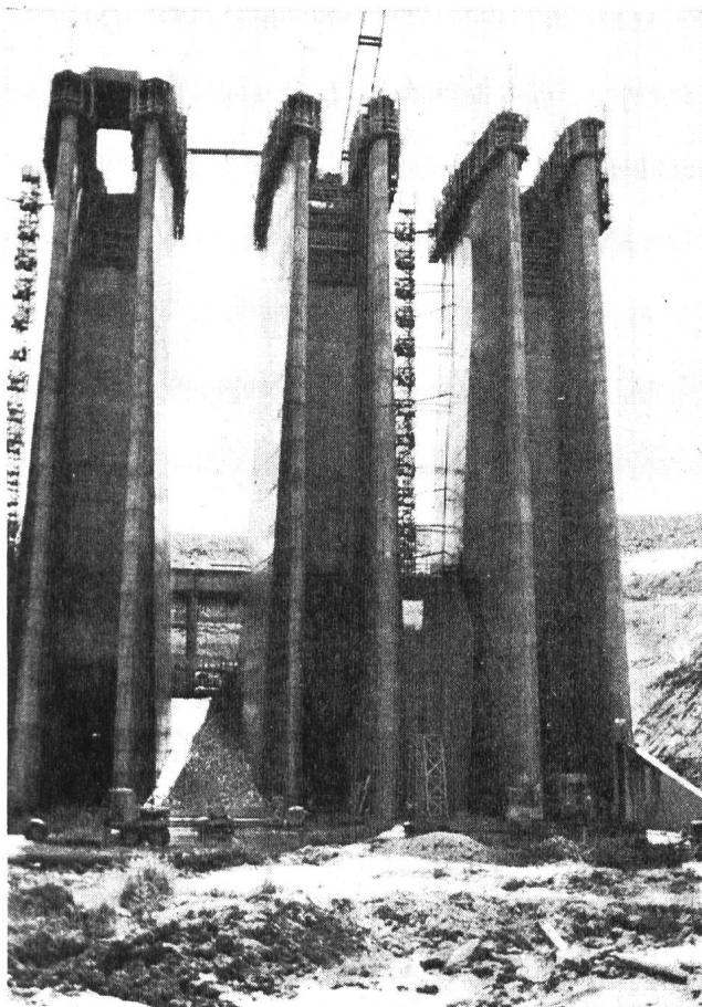
Abb. 19 Garrison Dam, Einlaufbauwerk
