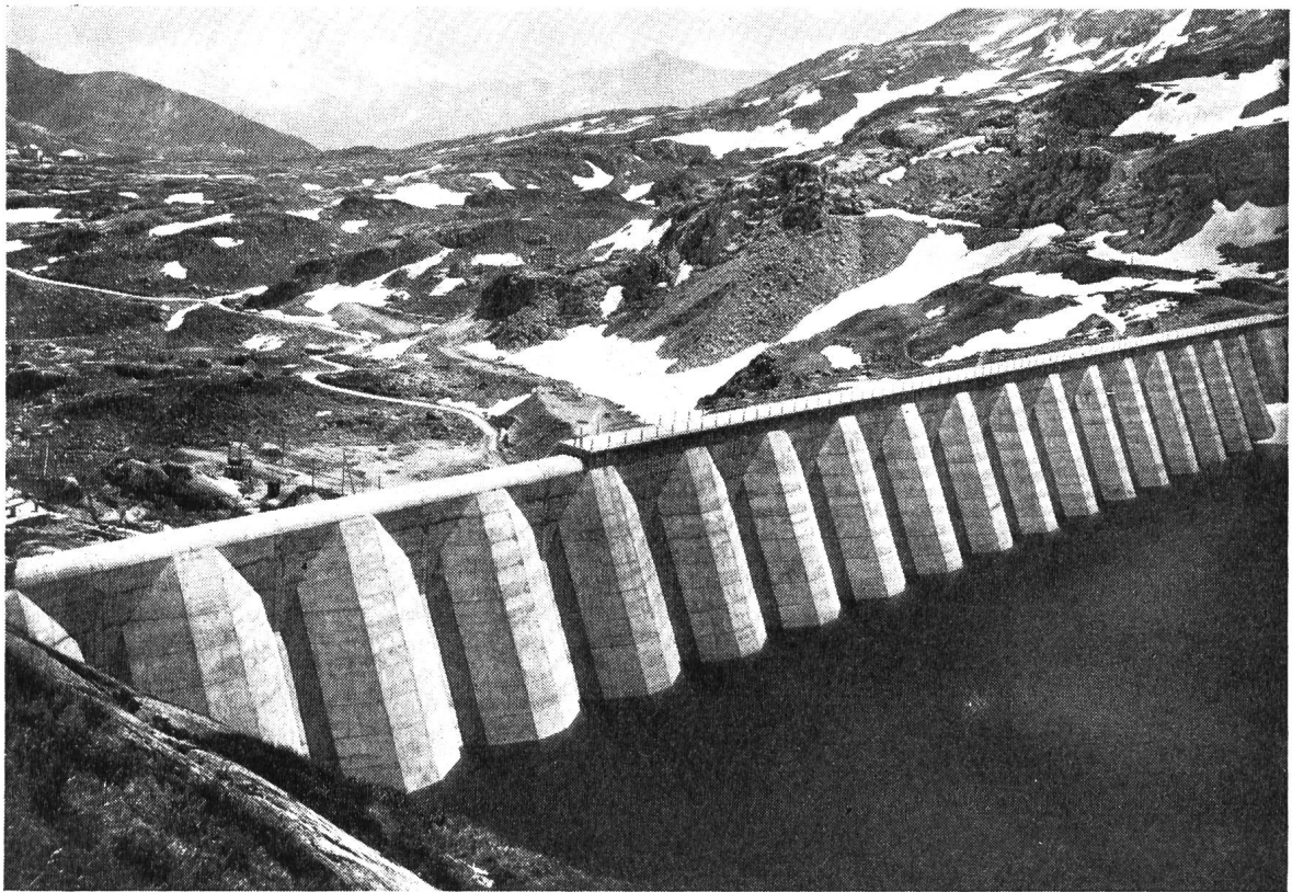
Abb. 5 Staumauer Lucendro, von der Wasserseite gegen die Gotthardpaßhöhe gesehen
