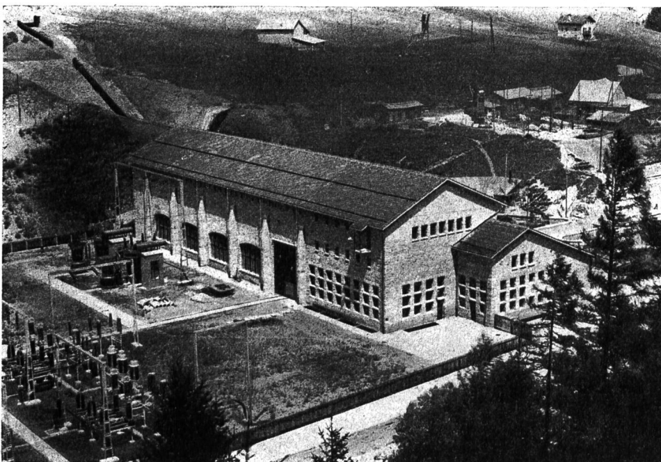
Abb. 4 Druckleitung, Maschinenhaus und Freiluftanlage des Kraftwerkes Lucendro in Airolo
