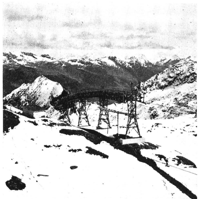
Abb. 7 Transportseilbahn von Rodi-Fiesso nach der Sperrstelle Sambuco; Blick gegen die Valle Leventina
