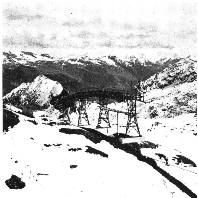
Abb. 7 Transportseilbahn von Rodi-Fiesso nach der Sperrstelle Sambuco; Blick gegen die Valle Leventina
