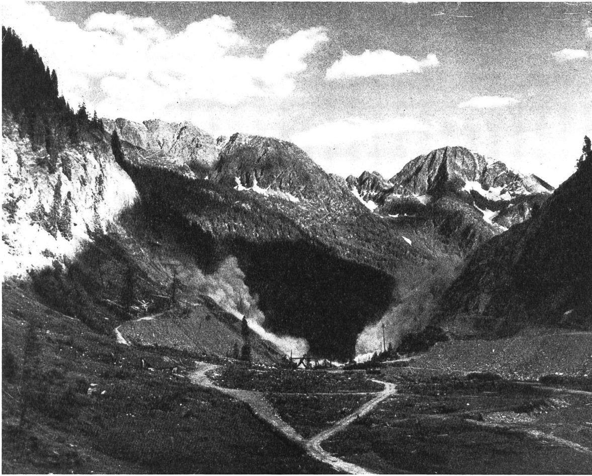
Abb. 4 Sperrstelle Sambuco beim Sprengen, talauswärts gesehen gegen Pizzo di Ruscada
