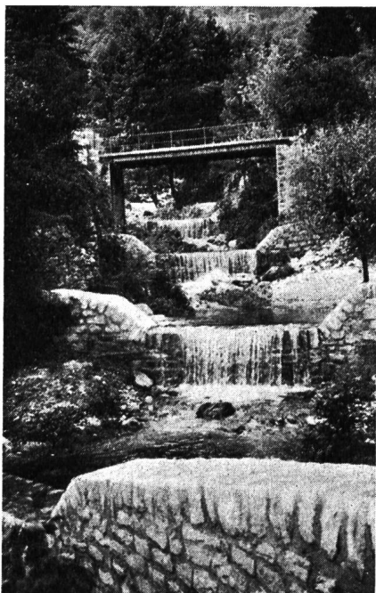
Abb. 1 Sperrtreppe am Rabissale bei Locarno
