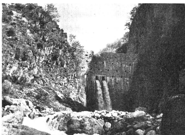
Abb. 3 Hauptsperre im Valle d'Arbedo, nach der ersten Überhöhung (1950)
