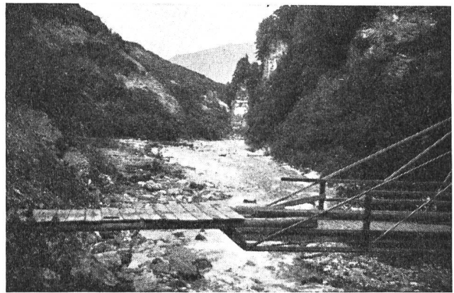
Abb. 9 Einfache Kragbalkenbrücke über den Glenner bei Surcasti. Rechts die standfesten, steilen Bündnerschieferwände, an denen die Brücke einseitig aufgehängt ist, links der flache Rutschhang des Lugnez
