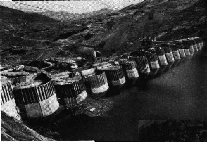
Staumauer Lucendro im Bau
