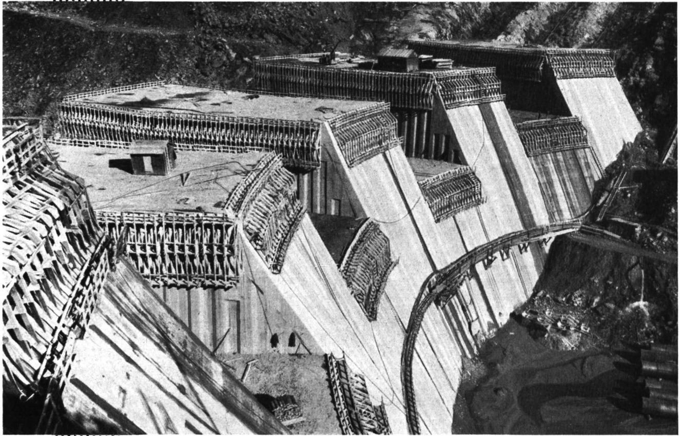
Staumauer Sambuco der Maggia-Kraftwerke AG, Locarno. Betonierung mit Zusatz von BARRA-55-Vinsol.
