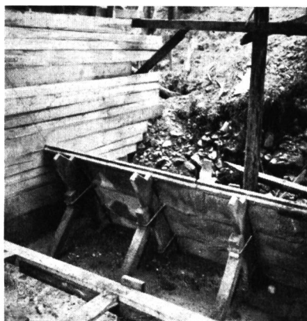
Abb. 17 Neuartige Staumauer-Betonschalung aus vorfabrizierten, armierten Betonelementen (Photo M. Thut, NOK, Baden)
