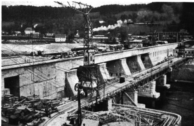
Abb. 12 Ennskraftwerk Rosenau kurz vor der Bauvollendung (Photo Th. Kuster †, Uznach)
