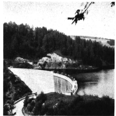
Abb. 14 Hierzmansperre der Teigitschkraftwerke (Photo M. Thut, NOK, Baden)
