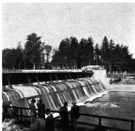
Abb. 3 Überflutbares Saalach-Kraftwerk Rott-Freilassing der Städtischen Elektrizitätswerke Salzburg. Links Ansicht des unterwasserseitigen Wehrkörpers mit Klappschützen, rechts das Wehr bei Überflutung
