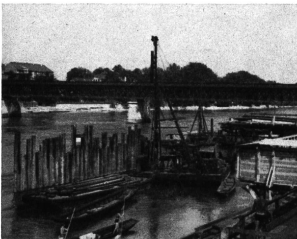
St. Albanbrücke, Rammarbeiten 1953
