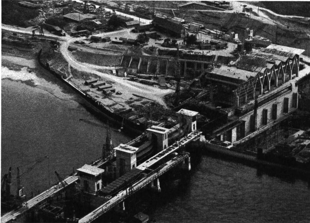
Kraftwerk Birsfelden, erbaut unter Verwendung von PLASTIMENT und FRIOPLAST
