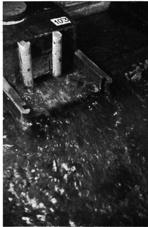
Abb. 6 Turbinenentlastung durch eine Spiralenöffnung bei NSQ = 700 \text{ m}^3/\text{s} .
