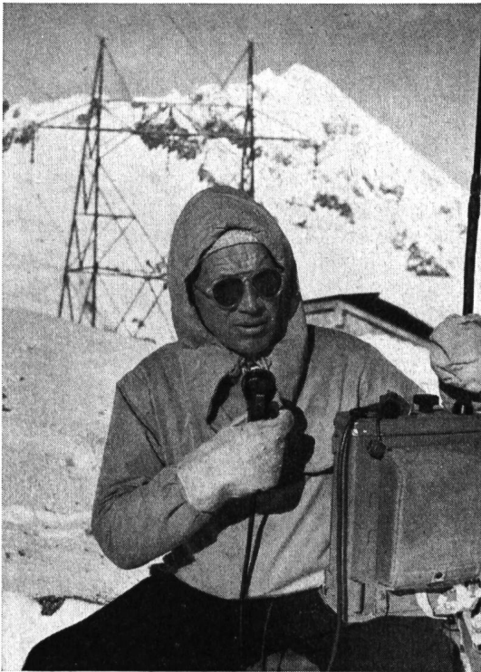
Abb. 4 Anwendung im Leitungsbau: Der Monteur steht in dauernder Sprechverbindung mit der Berghütte, von wo das Kraftwerk telephonisch erreichbar ist; so geht z. B. nach Beheben des Schadens die Meldung «Einschalten» vom abgelegenen Standort sofort zur Betriebsleitung.
