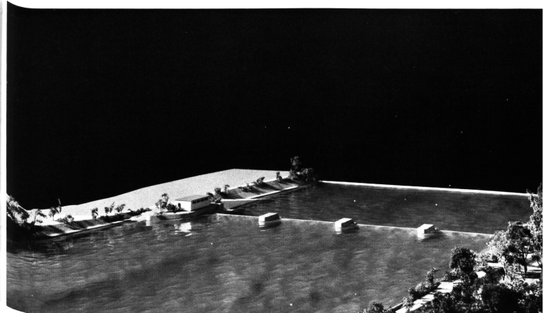
Abb. 13 Oberes Hilfswehr mit Reguliergebäude und Kahnrampe; am rechten Ufer Fischzuchtanstalt Stoll. Modellaufnahme vom Oberwasser
