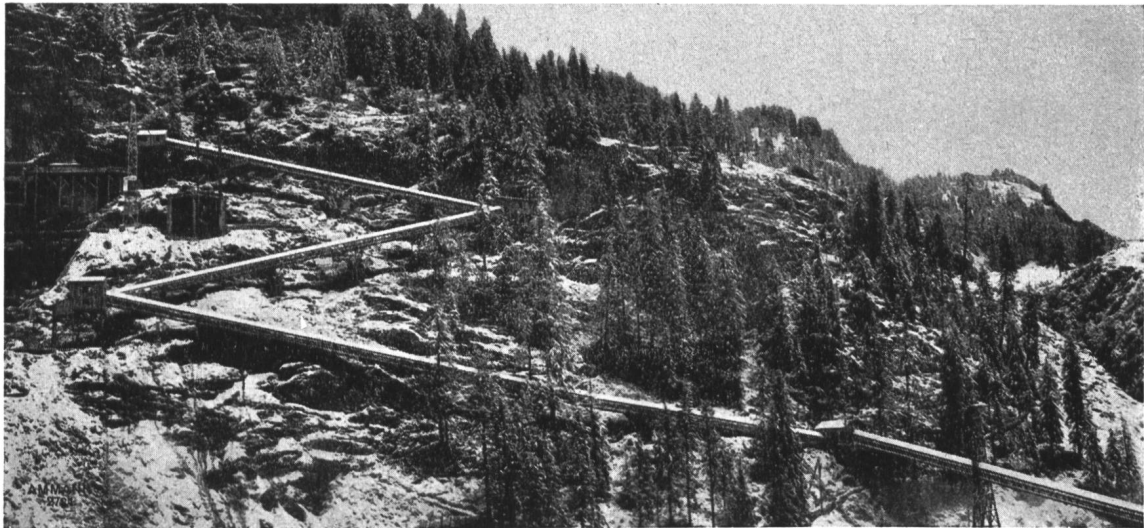
Transportbandanlage am Staumauerbau Sambucco (Maggia).
