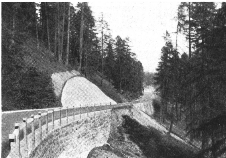
Neue Julierstrasse bei Marmorera
