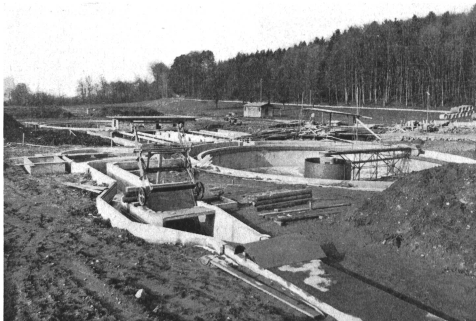
Abb. 15 Mechanisch-biologische Abwasserreinigungsanlage der Gemeinde Uster (Bauzustand Januar 1955), Ausbaugröße 16 000 E plus Industrie. Im Vordergrund Zulaufkanal mit automatischer Rechenanlage System Passavant, dahinter Sandfang System Geiger, rechts Vorklärbecken mit mechanischem Schlammkratzer System Dorr, links hinten Belebtschlammanlage und Nachklärbecken.
