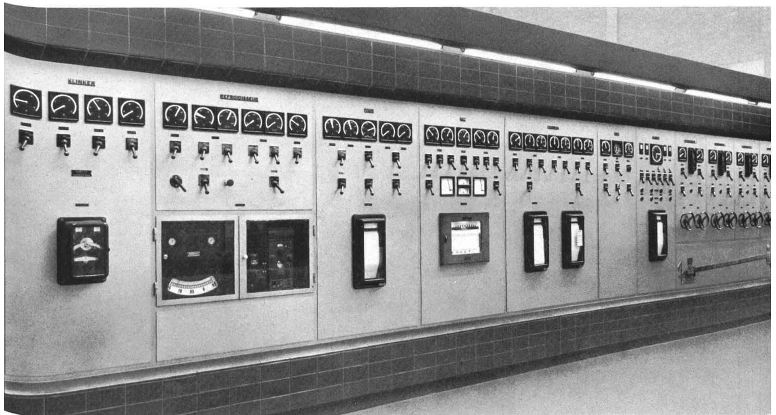
Meß- und Steuertableau mit angebaurem Schreibpult
