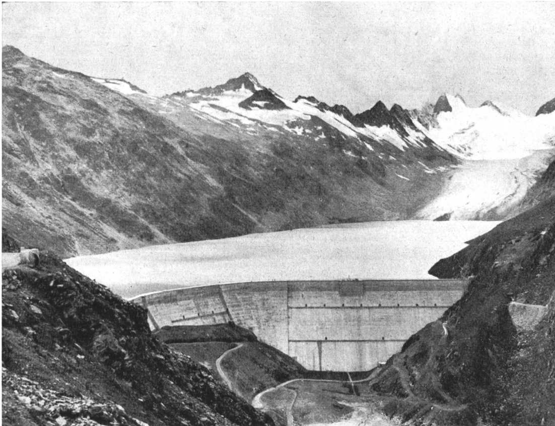
Abb. 3 Staumauer und Stausee Oberaar mit Oberaargletscher nach Vollendung der Bauarbeiten im Herbst 1954
