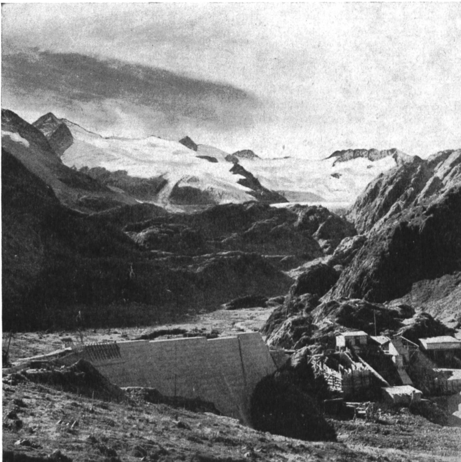
Abb. 4 Staumauer Mattentalp mit Gauligletscher; Stand der Arbeiten Herbst 1949.
