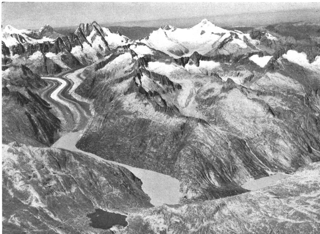
Abb. 1 Einzugsgebiet der Kraftwerke Oberhasli, westlicher Teil. Links Schreckhörner mit Unteraargletscher und Grimselstausee, im Vordergrund Totensee; rechts, im Hintergrund Wetterhörner mit Gauligletscher, davor Bächli-, Gruben- und Ärlengletscher mit Stausee Räterichsboden.
