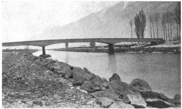
Fig. 6 Correction du Rhône Branson—Fully, 1936—1938
