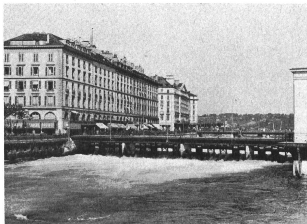
Fig. 2 Barrage à rideaux du Pont de la Machine à Genève, pour le réglage des niveaux du Léman. Vue d'aval. (Photographie A. Kern, Genève, obligeamment remise par le Service des eaux de Genève.)
