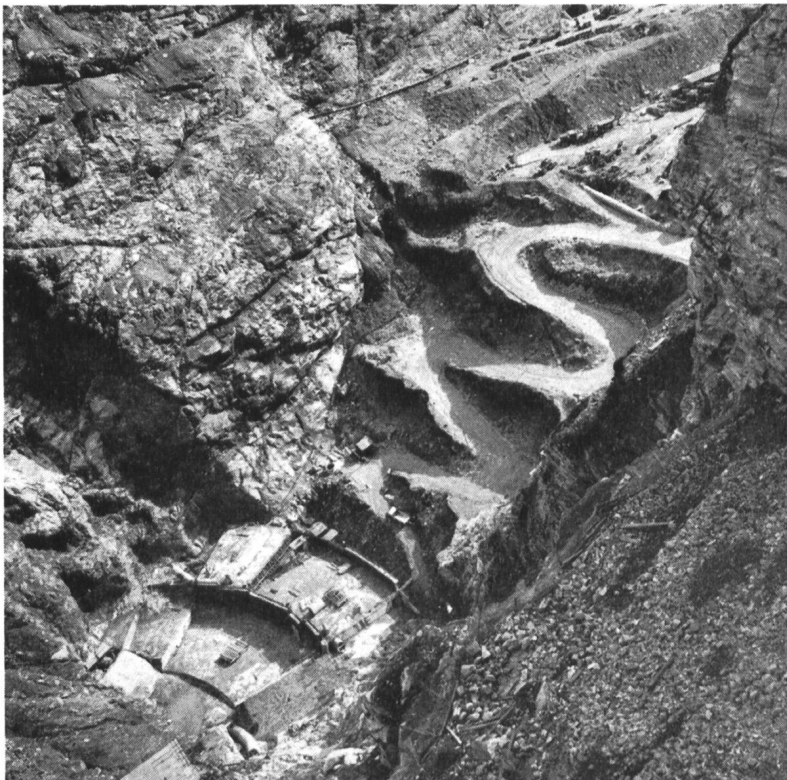
Fig. 6 Barrage, fond de fouille (novembre 1954)
