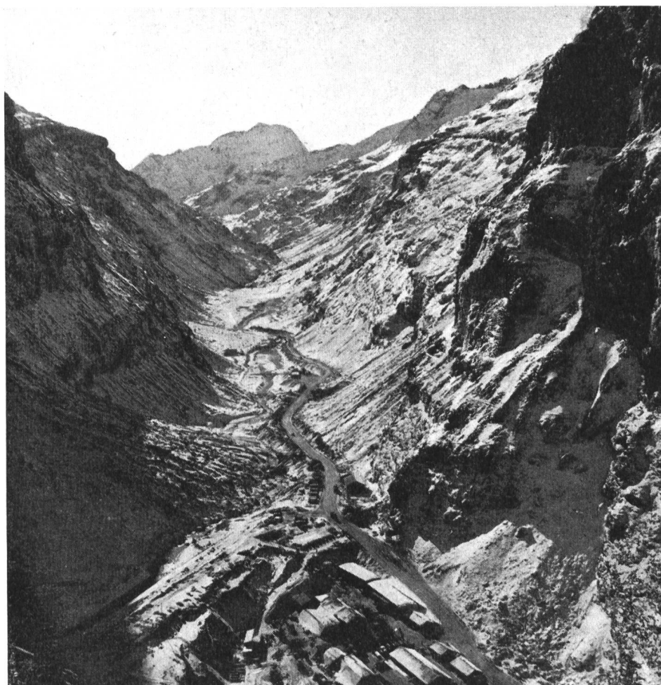
Fig. 3 La future retenue de Mauvoisin (vue prise de l'emplacement du barrage)
