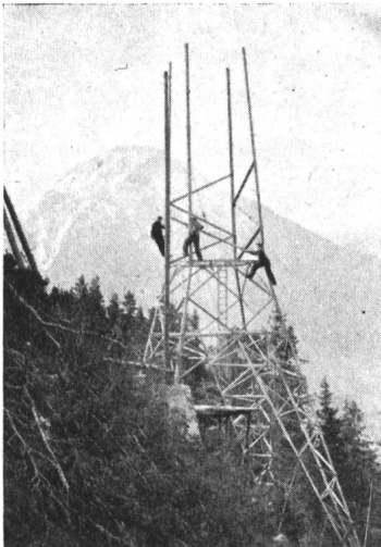
Montage eines Hochspannungsmastes
