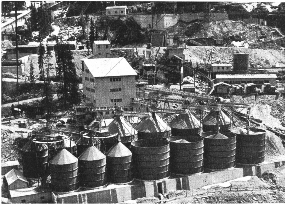
Siloanlage Staumauer Zervreila. Inhalt = 13 000 m 3
