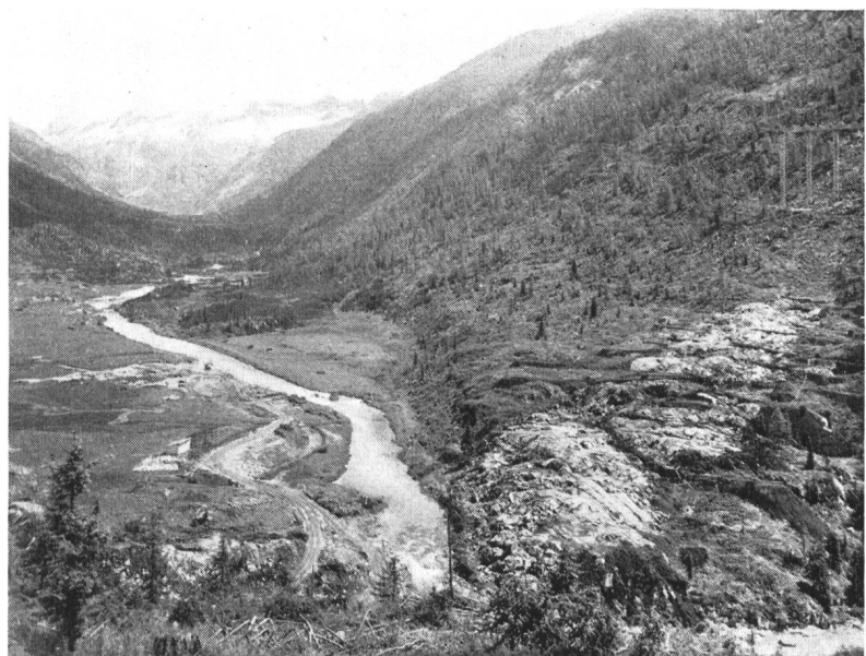
Abb. 2 Speicherbecken Malga Bissina im obersten Chiesetal mit Felsabdeckung der Fundamentfläche auf der linken Talflanke. (Photo S. E. M. / Soc. Edison)
