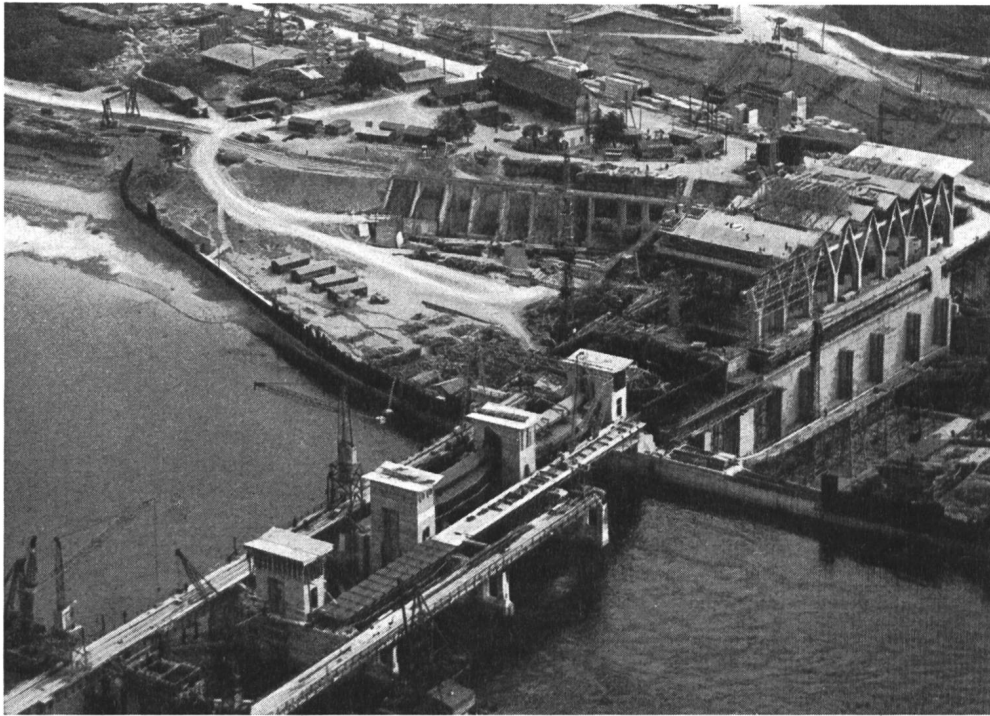
Kraftwerk Birsefeld, erbaut unter Verwendung von PLASTIMENT und FRIOPLAST
