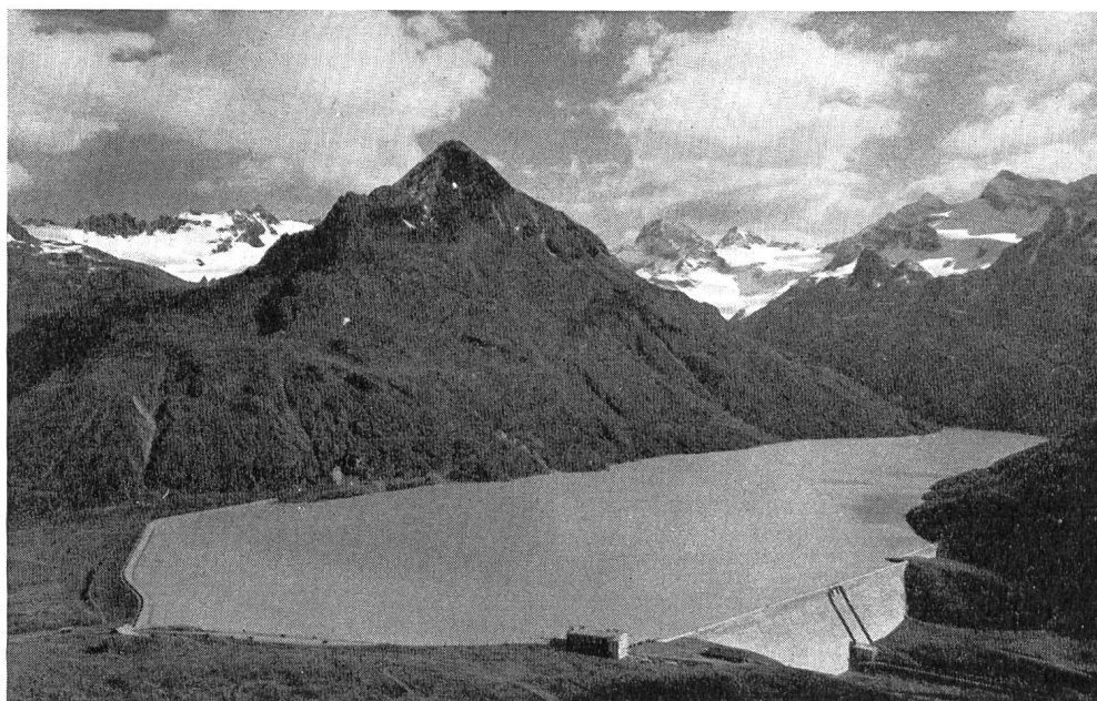
Abb. 3 Silvretta-Stausee mit Staumauer und Bielerdamm; im Hintergrund rechts Groß und Klein Buin, Silvretthorn. (Photo Vorarlberger Illwerke AG)
