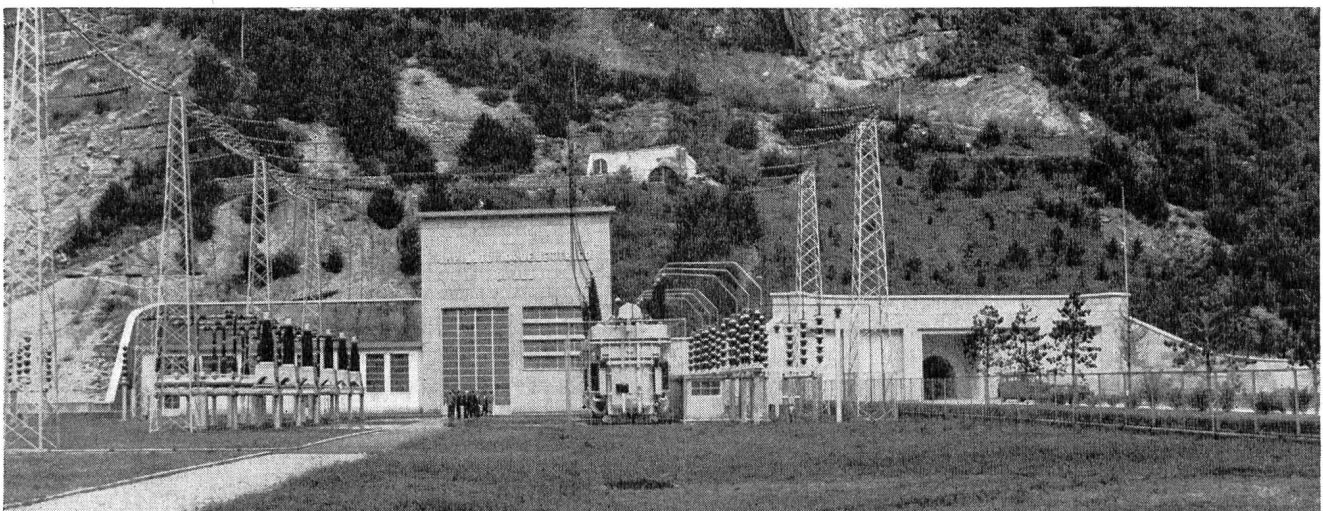
Abb. 8 Ersch-Kraftwerk Ala; Freiluft-Schaltanlage, Verwaltungsgebäude und Eingang zur Kavernenzentrale (Photo G. A. Töndury)
