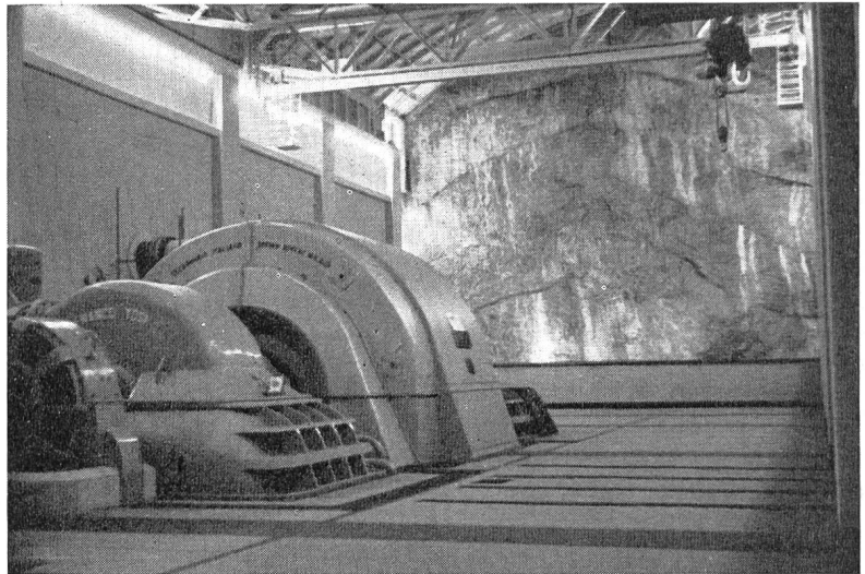
Abb. 2 Kraftwerk-Kaverne S. Massenza, Teilansicht mit unverkleideter Abschlußwand (Photo M. Gerber, Zürich)
