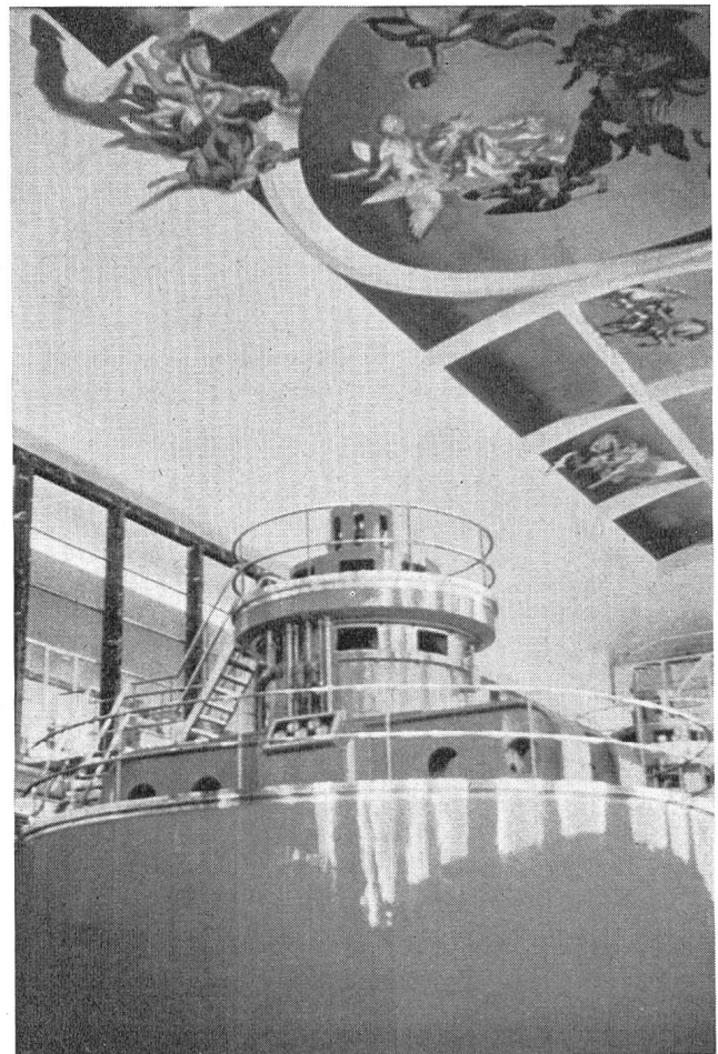
Abb. 5 Kavernenzentrale Achille Gaggia/Soverzene, Maschinensaal mit Deckengemälde (Photo G. A. Töndury)
