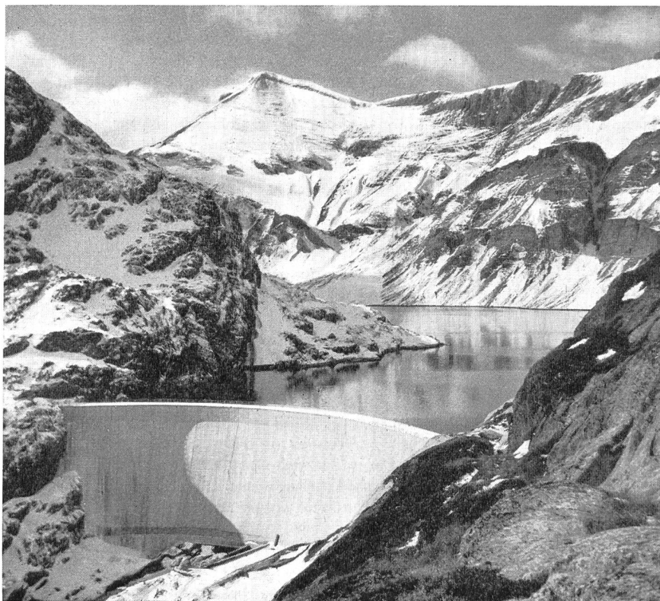
Barrage de Vieux-Emosson (Valais), barrage poids-voûte
