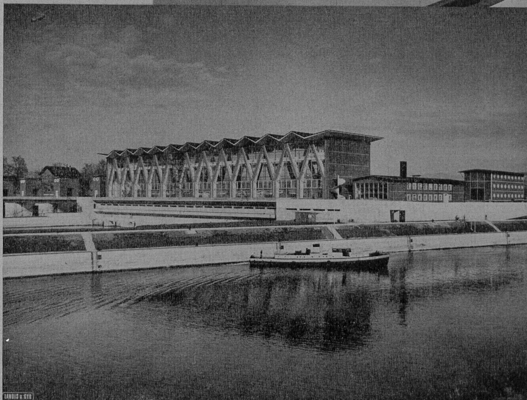
Kraftwerk Birsfelden mit Fernzählanlage Landis & Gyr
