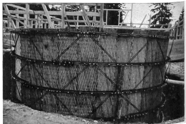
Wasserreservoir mit BK-Trägern
