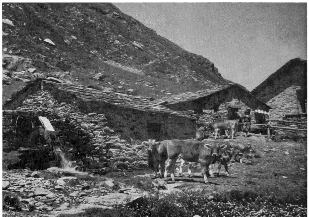
Abb. 43 Heutige Wasserkraftnutzung im Valle di Lei
