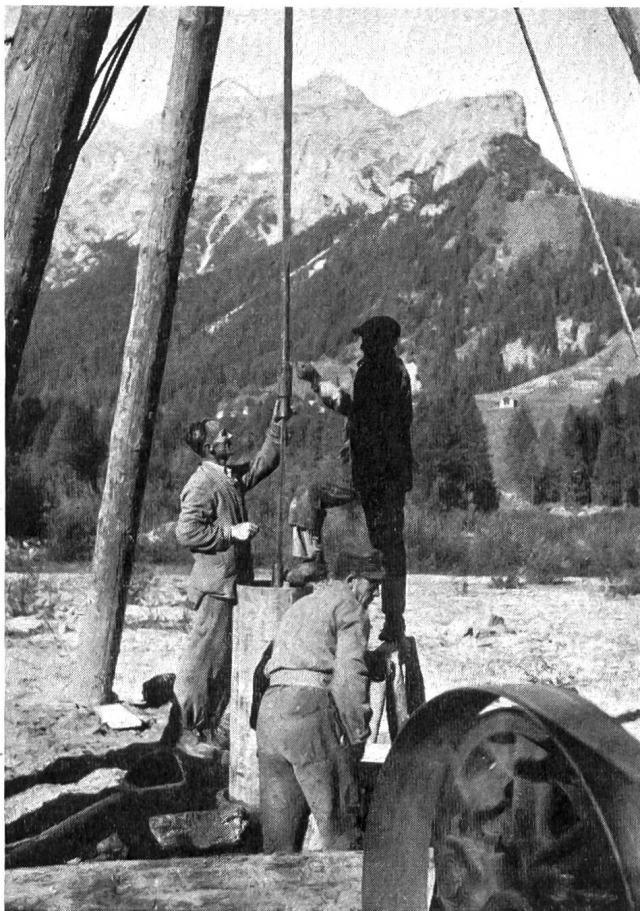
Abb. 45 Sondierungen im Talboden von Sufers, Aufnahme September 1948
