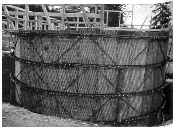
Wasserreservoir mit BK-Trägern
